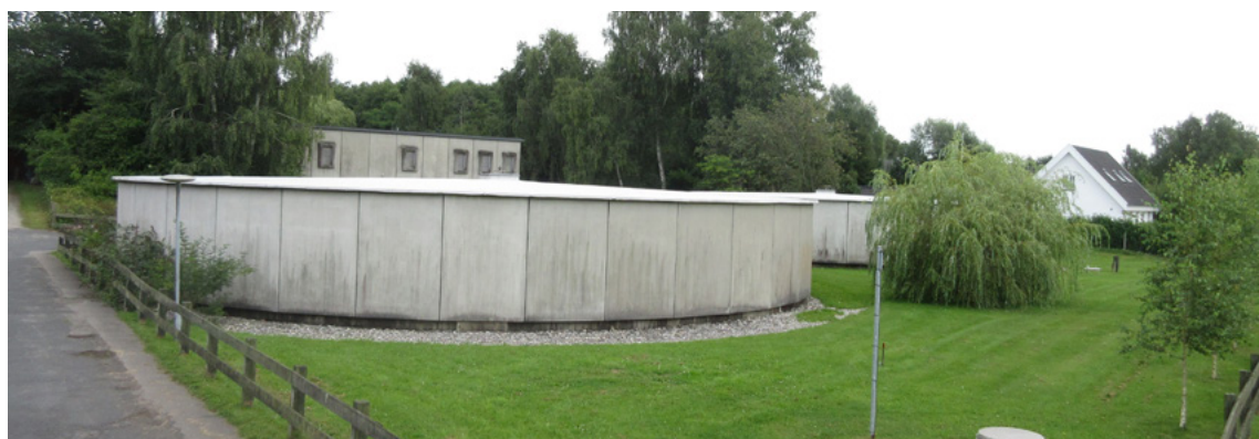
Hillerød Forsyning foreslår, at Nødebos varmecentral til fjernvarme placeres her, ved vandværket på Stenholtvej.
