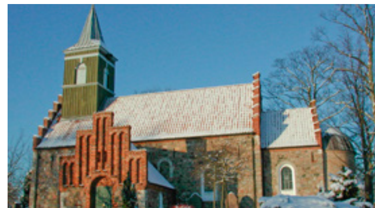
Kirken har fået lagt et nyt, rødt tag med håndstrøgne tagsten. Alle kamtakterne har fået nye "nonner" og "munke".
